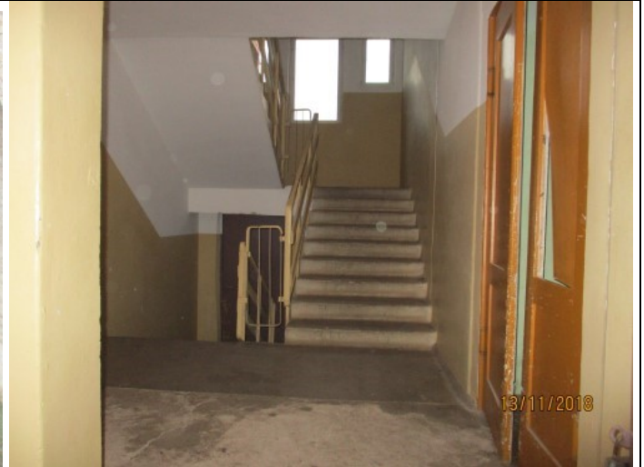
4.10.2. att. Starpstāvu dz-betona konstr. kāpnes
