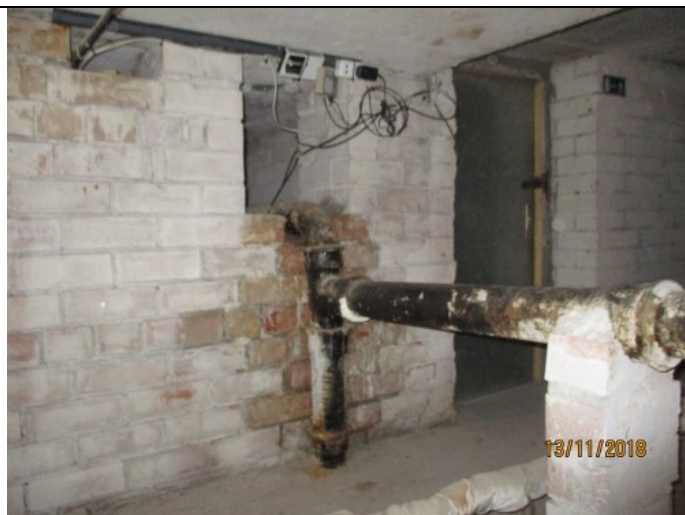
4.8.12. att. Causūkšanās lietūs ūdens novadīšanas sistēmai
