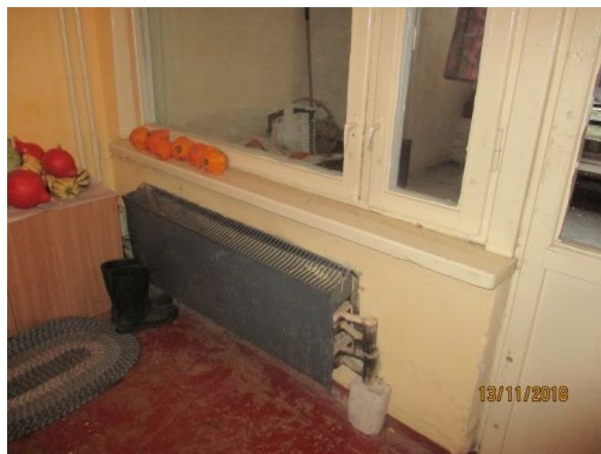
5.5.1. un 5.5.2. att. Apkures sistēmas konvektori koplietošanas telpās
