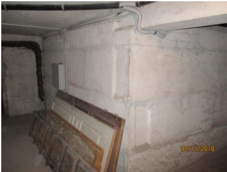
4.1.5.att. Dz-betona gatavbloku pamati
