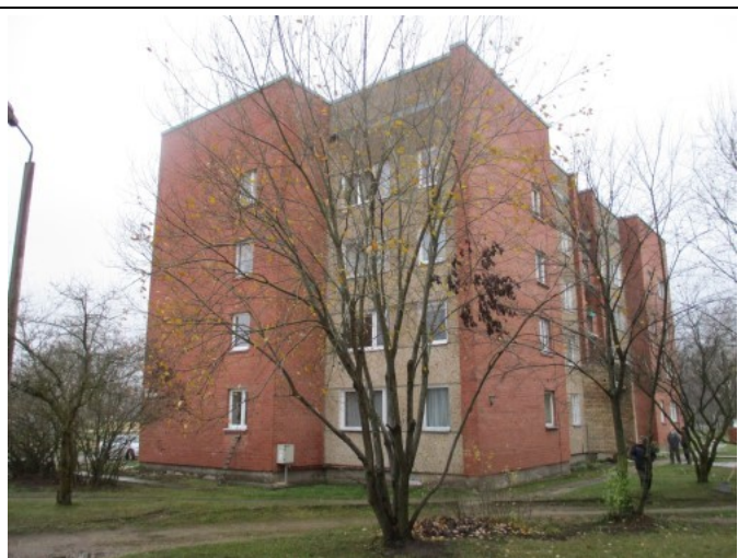
4.19.8. att. Ēkas DA puses fasāde
