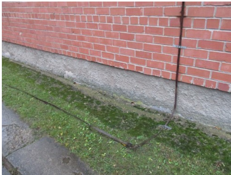
5.9.1. att. Zemējuma kontūrs izvadīts virs grunts blakus ietvei
