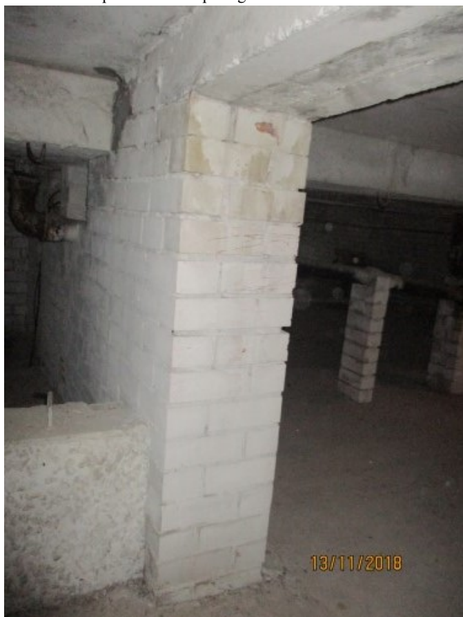
4.8.3. att. Jumta konstrukciju mūra balstsienas
