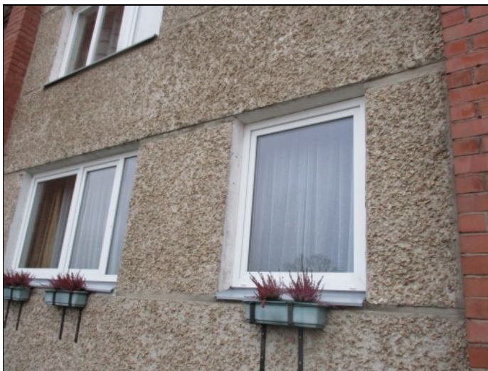
4.13.1.att. PVC konstrukcijas logi dzīvokļos
