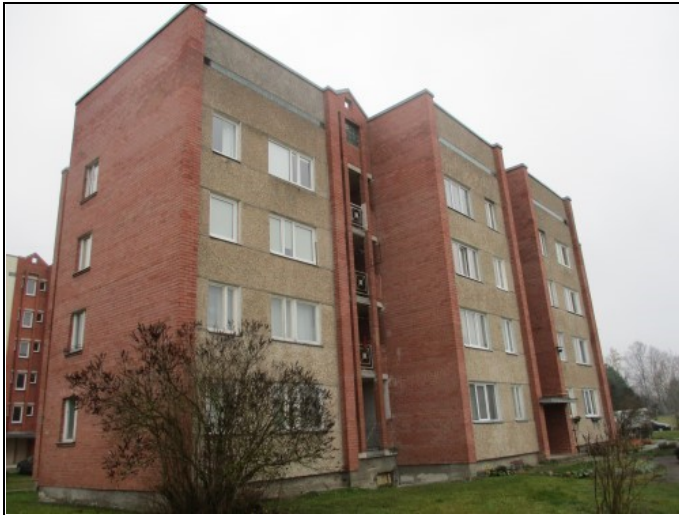
4.19.4. att. Ēkas ZR puses fasāde
