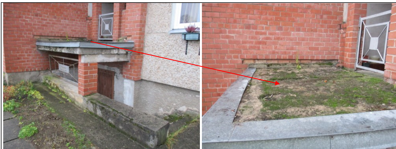
4.9.3. un 4.9.4. att. Bojāts ieejas mezgla jumtiņa segums
