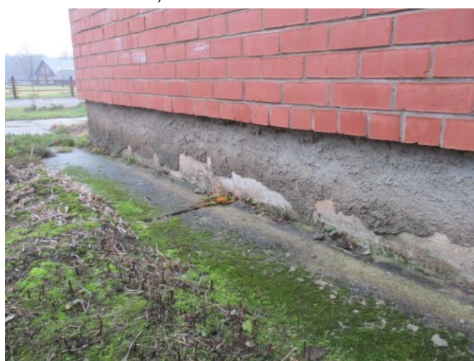
4.1.1. un 4.1.2. att. Ēkas cokols un betona apmales
