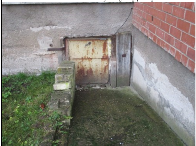
4.13.5. att. Koka konstrukcijas lūka ar skārda apdari
