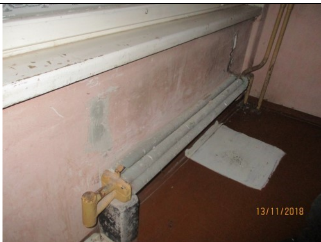
5.5.3. att. Apkures sistēmas konvektori koplietošanas telpās
