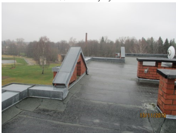
4.8.7. att. Bitumena ruļļmateriāla jumta segums
