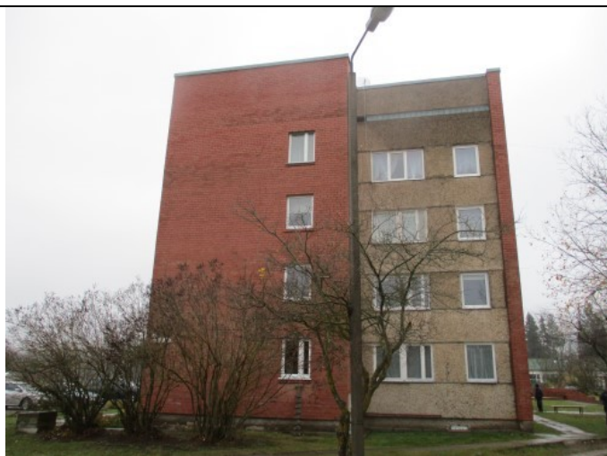
4.19.9. att. Ēkas dienvidu puses fasāde
