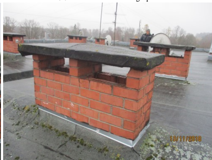
4.8.8. att. Apkausēti virsumta daļas mūra vēdināšanas izvadi
