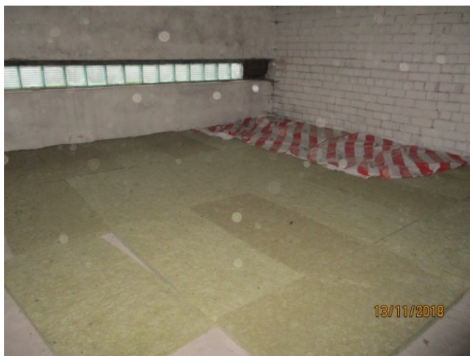
4.8.1. att. Papildus siltināts pārsegums ar minerālvati h = 50 mm
