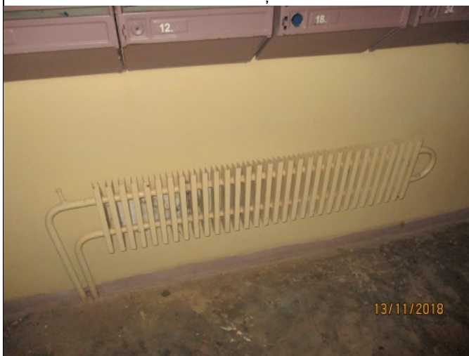
5.5.1. un 5.5.2. att. Apkures sistēmas konvektori koplietošanas telpās
