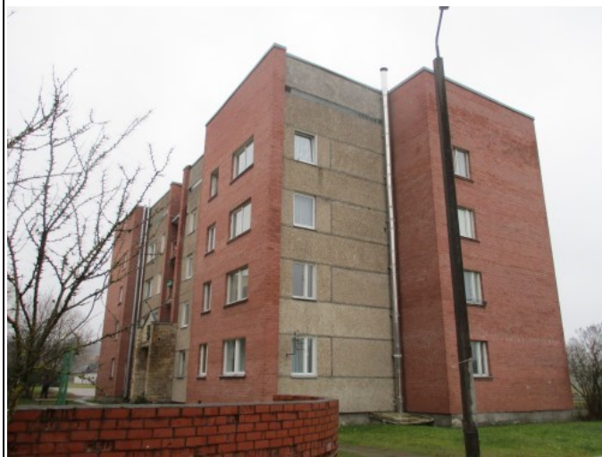
4.19.6. att. Ēkas ZA puses fasāde
