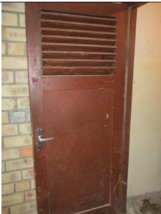
4.13.7. un 4.13.8. att. Koka konstrukcijas ārdurvis
