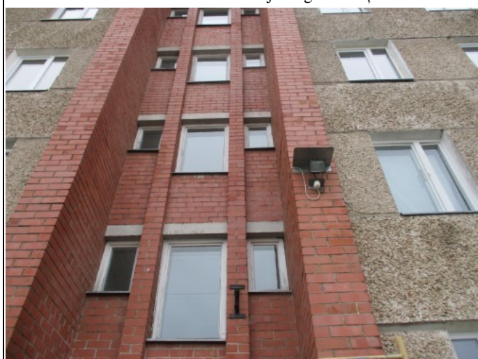
4.13.3. att. Koka konstrukcijas logi kāpņu telpās
