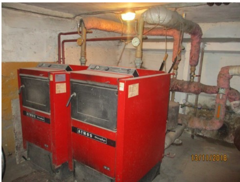
4.14.2. att. Malkas apkures katli, kas vairs netiek izmantoti
