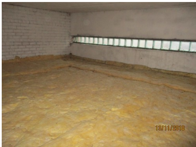
4.8.4. att. Papildus siltināts pārsegums ar minerālvati h = 2 \times 50 mm
