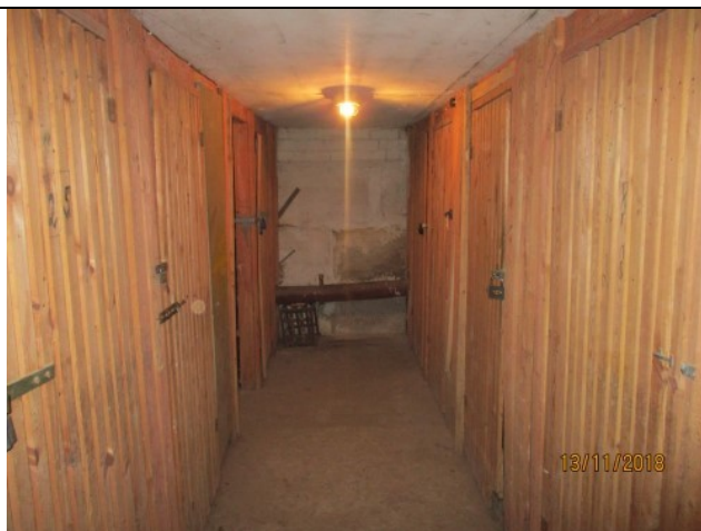
4.4.1. att. Koka konstrukcijas starpsienas pagrabstāvā
