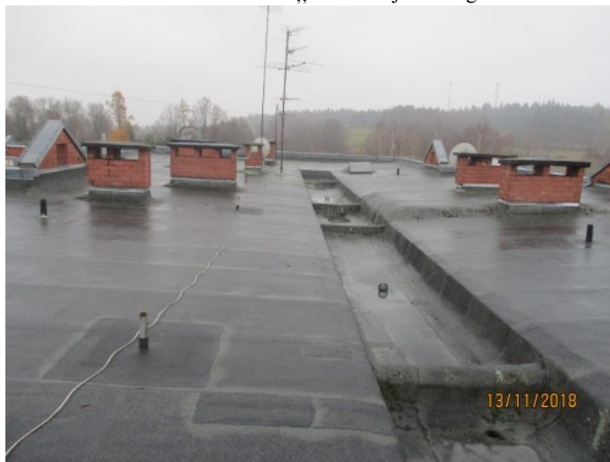
4.8.9. att. Iekšējām tehnēm nav pretgružu sietiņi
