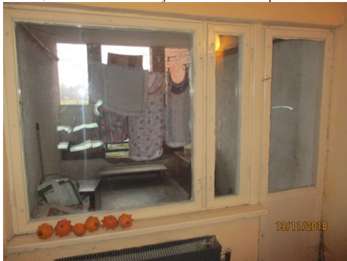
4.13.6. att. Koka konstrukcijas duvju/logu bloks lodžijām
